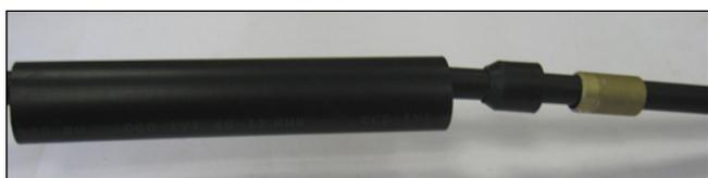
**Примечание** - При диаметре ОК от 11 до 13 мм одновременно с отрезком ТУТ 40/12 надвинуть отрезок ТУТ 19/6; при диаметре ОК от 6 до 11 мм надвинуть два отрезка ТУТ 19/6 (используются для увеличения диаметра ОК на участке усадки на ОК отрезка ТУТ 40/12).
