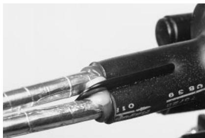
**6.7** Продолжайте усаживать трубку в сторону кабелей. Нагревайте до тех пор, пока трубка не усадится на кабели и зеленая термоиндикаторная краска не станет черной. Этап нагрейте зажим с обеих сторон до тех пор, пока клей не выступит из зажима в промежутке между двумя кабелями.
