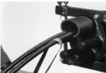
**6.2** Очищенные овальный ввод и оболочку кабеля обработайте по окружности наждачной полоской. Чистой тканью удалите все остатки обработки.
