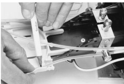
7.1.1 Каждый лоток рассчитан на максимум 8 сростков волокон и с каждой стороны лотка можно разместить максимум 4 больших переходных трубыки. Разместите трубки на дне лотка и выровняйте их по длине. Пометьте каждую трубку на лотке на расстоянии 15 мм от края лотка.
