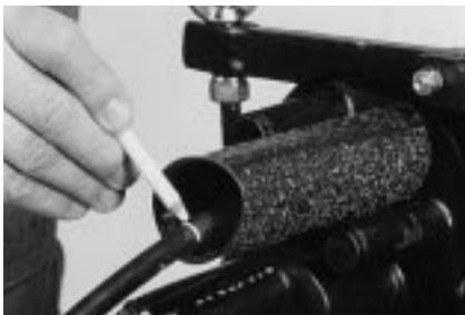
**11.8** Надвиньте термоусаживаемую трубку на кабельный ввод основания муфты FOSC до упора в основание. Отметьте длину трубы на оболочке кабеля.
