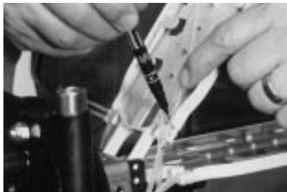
**8.2** Выполните сращивание волокон, как описано в пункте 7. Однако оставьте достаточный запас переходных трубок чтобы при повороте лотка на шарнире трубы сильно не изгибались и не перекручивались.
