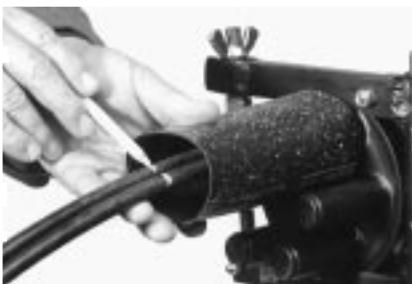
**6.3** Наденьте овальную герметизирующую трубку на овальный ввод и кабель. Пометьте длину трубки на кабеле.
