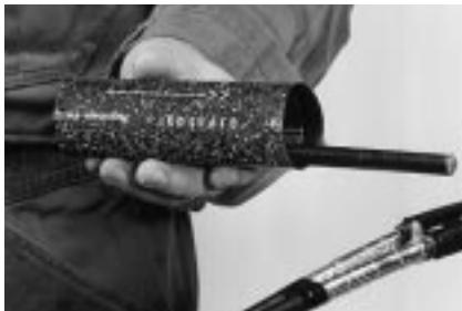
**11.2** Удалите чистой тканью землю, грязь и другие вещества с оболочки кабеля на длине около 2 метров. Возьмите герметизирующую трубку из комплекта FOSC-A-CSEAL-1-NT и наденьте ее на кабель. Неокрашенный край трубки и стрелки на трубке должны быть направлены к основанию муфты.
