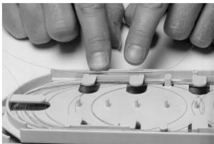
7.1.5 Каждый смонтированный сросток должен быть помещен в держатель сростков. Вставляя сросток в держатель не деформируйте защитную трубку. Запас волокна должен бытьложен витками на лотке.
